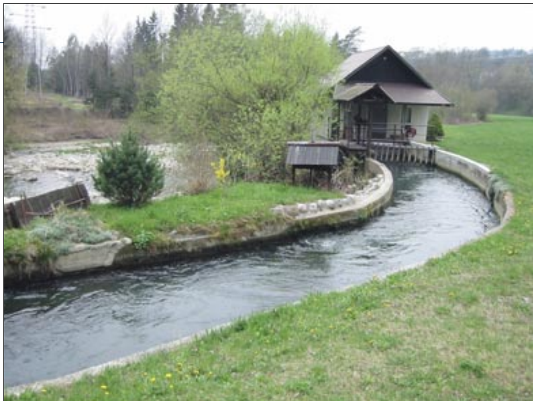
Mala hidroelektrarna Tržič
