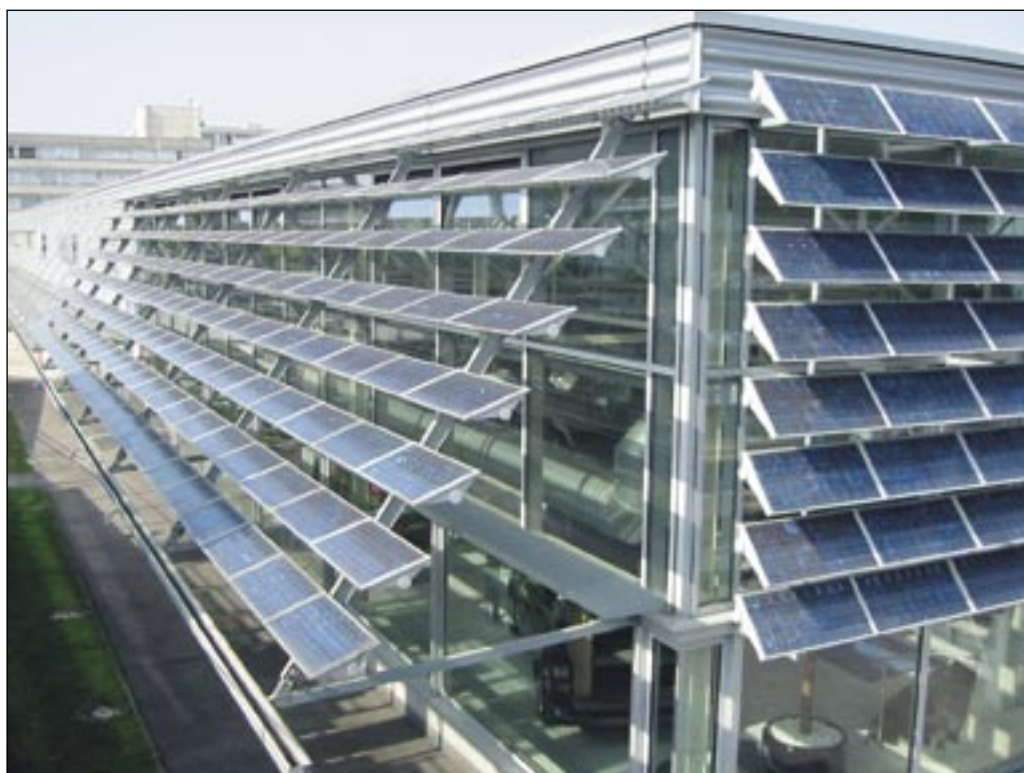
Fotovoltaični sistem na stavbi servisa Volkswagen v Švici
