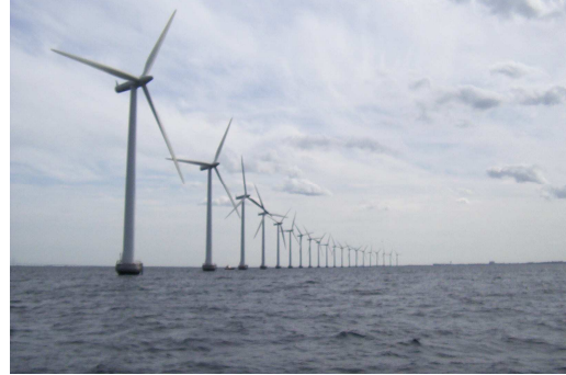
Offshore windfarm, Middelgrunden
