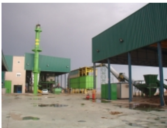
Planta de Gasificación de Nijar, Almería
