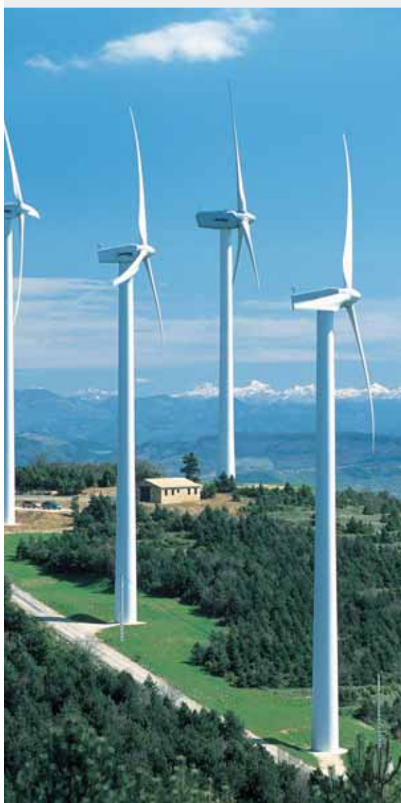
Aerogeneradores en el parque eólico de la Sierra de Izco-Salajones
