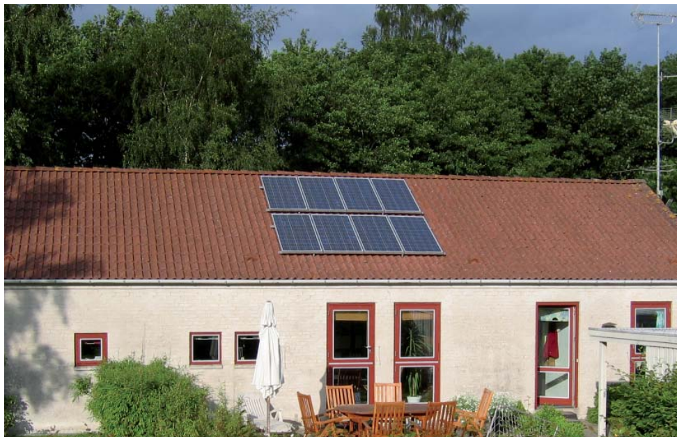
Billede 1 Traditionelt add-on anlæg oven på tagsten.
