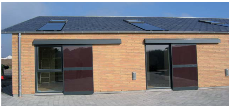
Billede 2 Integration af solceller. Krystallinske celler i taget og tyndfilmsceller i skydedøre
