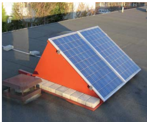
Billede 3 På fladt tag kan solcellerne monteres på en ballast kasse med god hældning
