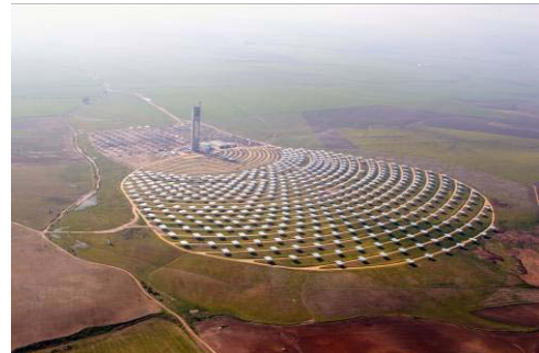
Planta Solar Termoeléctrica PS10 , 11MWe en Sanlúcar la Mayor, Sevilla
